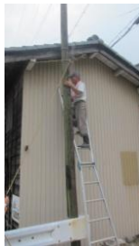
⑭案内板部会で有線放送時代の電柱撤去作業
