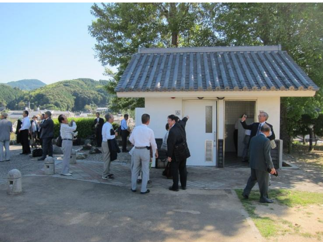
大洲城のトイレ写真を参考に黒野城のトイレが3月完成
