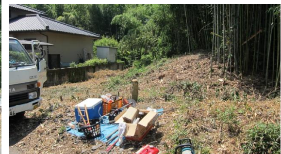
2次作業後の南方を望む
