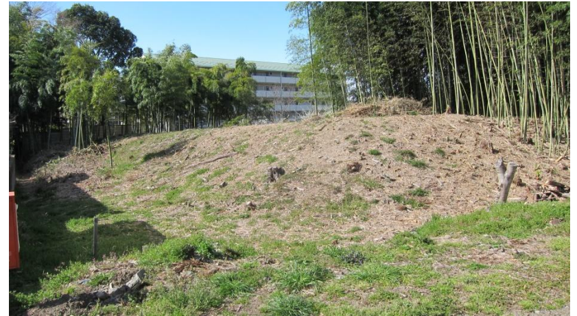
作業後(平成28年3月25日撮影)
