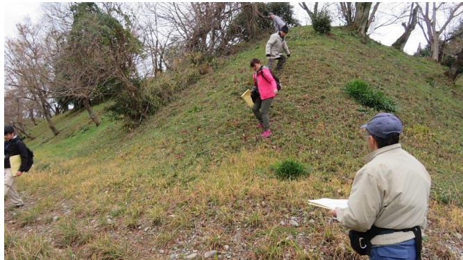
土塁下側に人工的に作られた段差があることを指摘。堀水の波で土塁が削れないように水際に段差の工夫がされていると初耳に関心寄せる。
