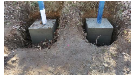
コンクリート型枠外し
