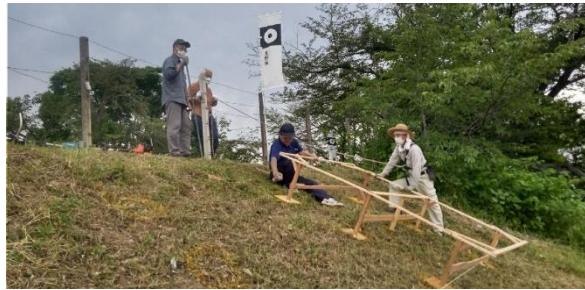
原寸ゲージで穴位置に黄色スプレーマーキング
