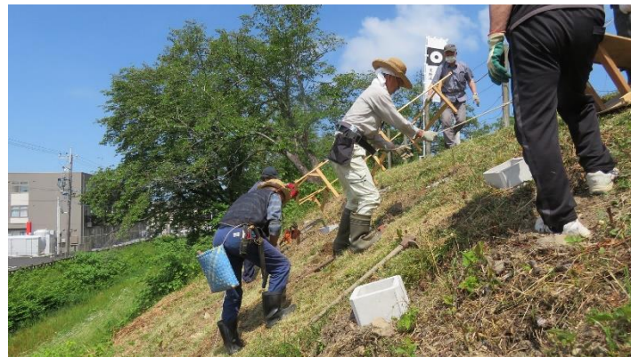
根を切り石を除去し枡形コンクリート枠埋込
