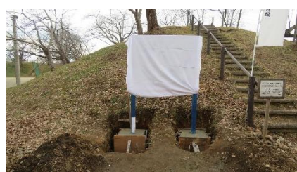
コンクリート充填完了
