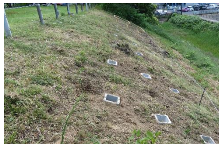
枡形コンクリート枠埋込
