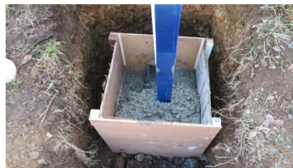
コンクリート充填途中
