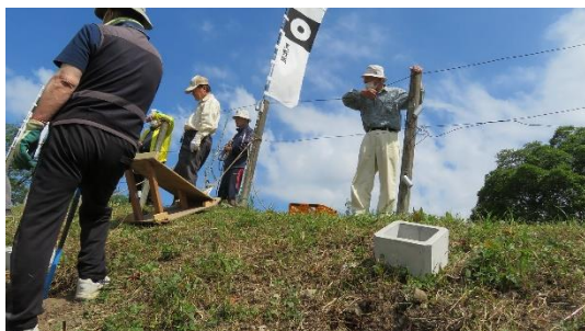
45° 斜面での作業はきつい
