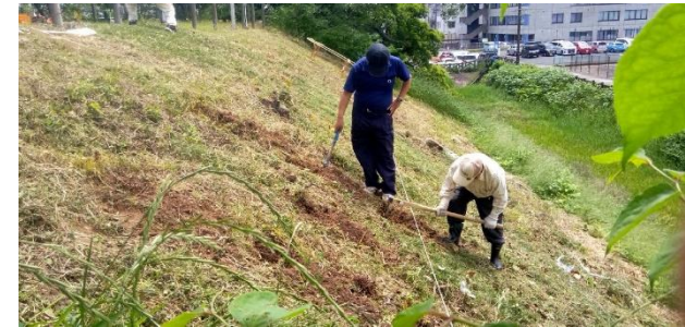
マーキング部の穴掘り作業
