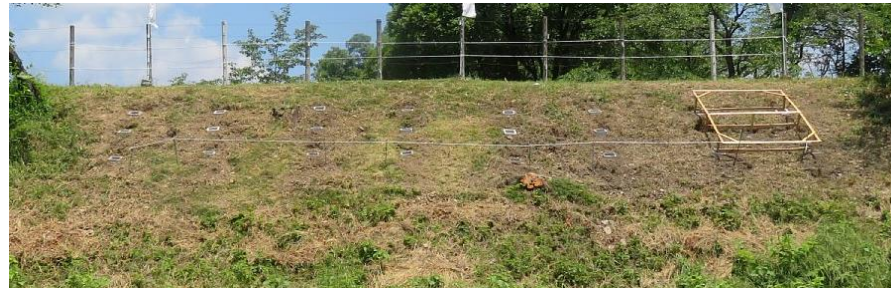
コンクリート枠埋込完成
