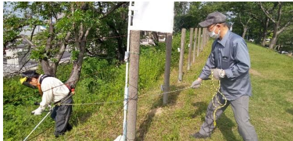
命綱を付けて45° 斜面の草刈り(3台)
