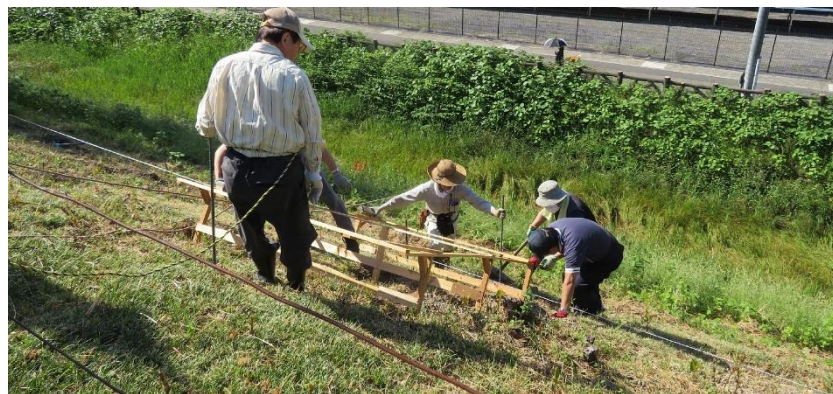
原寸サイズ(幅1.8m×高さ2.5m)ゲージで穴位置修正
