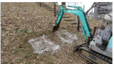
ショベルカー穴掘り
