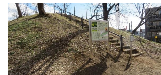
完成状況 斜視
