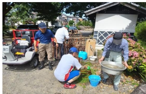
高圧洗浄器・ブラシによる洗浄 ①
